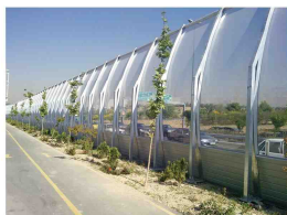
دیوار صوتی اتوبان حکیم (ورق تخت ۱۲ میل شفاف)
